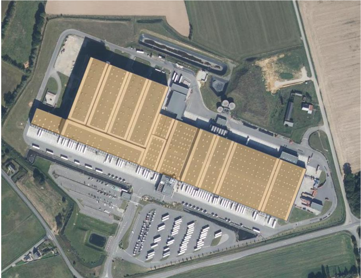
Surface de toiture de la base logistique à Erbrée
