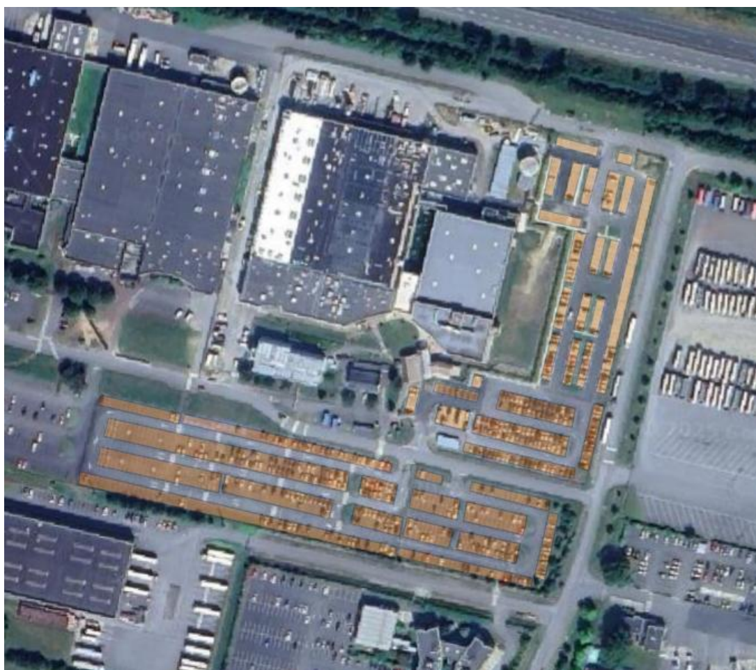
Photographie aérienne du parc de stationnement dédié à l'entreprise THALES
