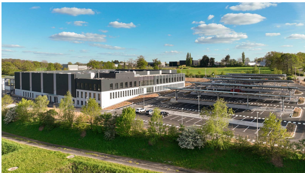
Photographie du parc de stationnement équipé de panneaux photovoltaïques sur ombrières de l'entreprise IDEMIA à Vitré
